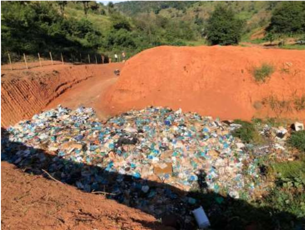
Figura 3 – Vala de resíduos do Aterro de Paulistas
