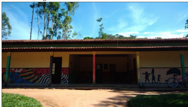
Figura 6 – Fachada da escola da Comunidade
